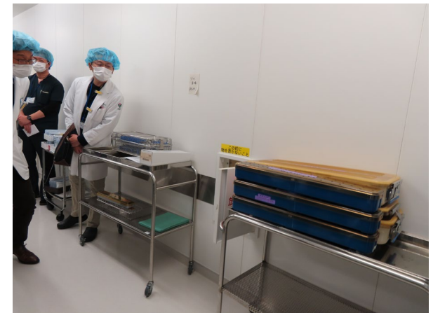
消防用消火栓の確認
