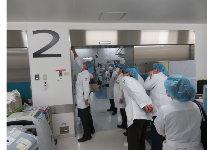
防火扉の手動切換え
